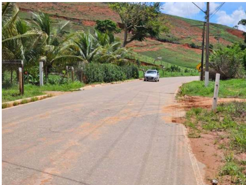
Foto 02: trecho de construção da pista de acessibilidade
