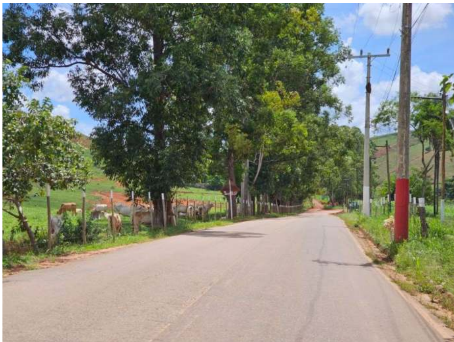
Foto 03: trecho de construção da pista de acessibilidade;
