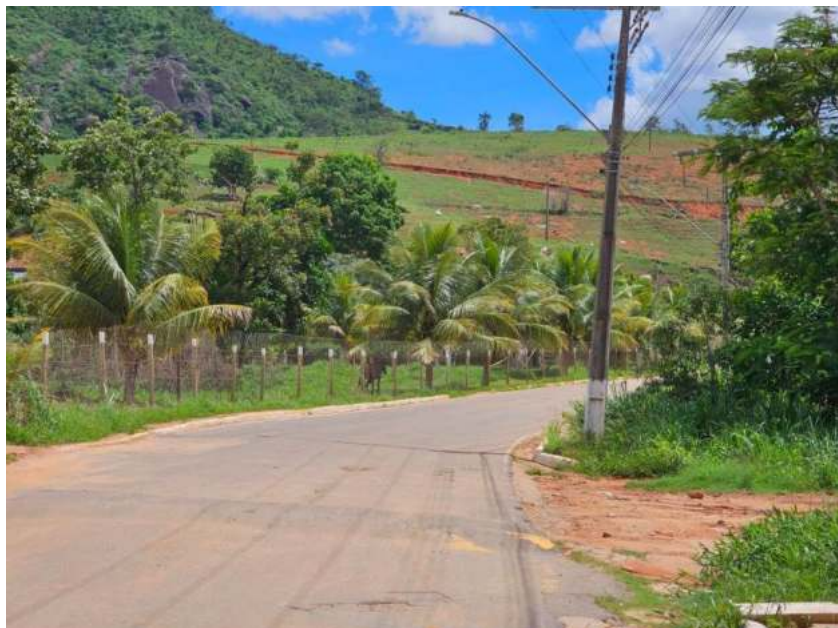
Foto 01: Início do trecho
