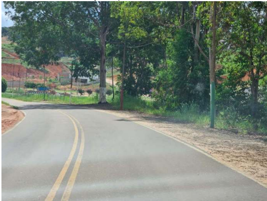
Foto 06: trecho de construção da pista de acessibilidade;
