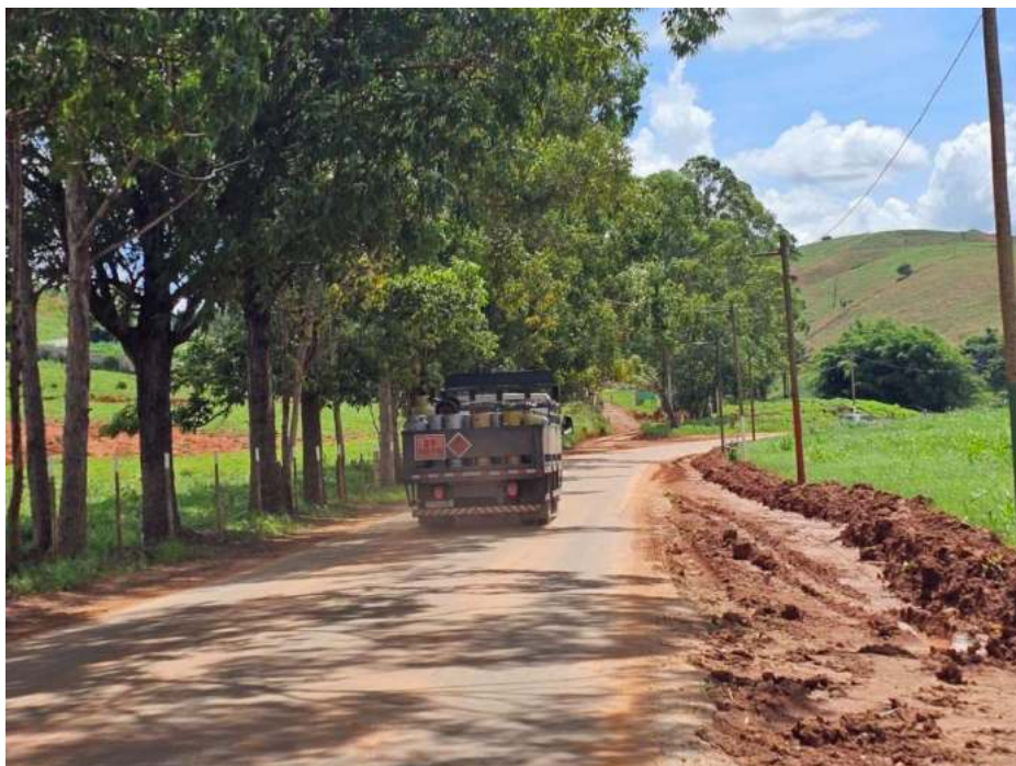
Foto 04: trecho de construção da pista de acessibilidade;
