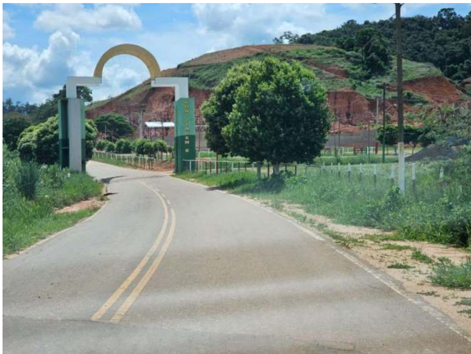
Foto 07: trecho final da pista de acessibilidade ao bairro Novo Horizonte, portal de entrada da cidade;
