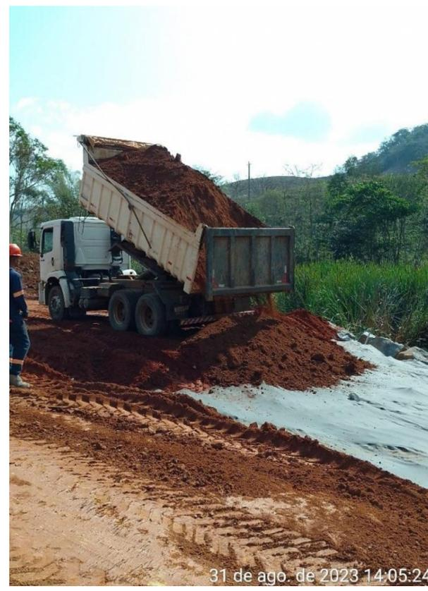
**Alargamento de pista ente as Estacas 179 e 186, onde executou-se retirada do solo mole enrocamento**
